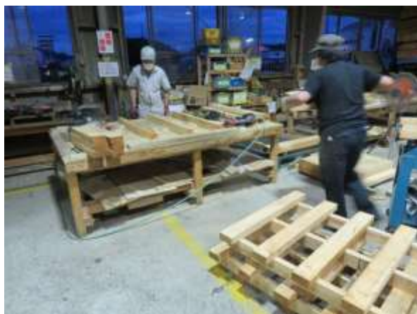
夕闇迫る中、枠台製作の作業
